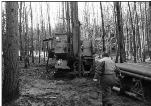
Práce na novém vrtu
